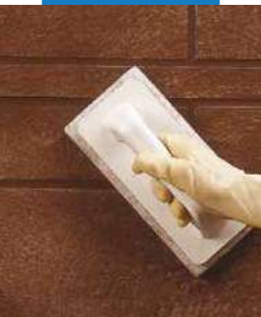
Nanášanie Ultracolor Plus na stenu s gumovou stierkou
