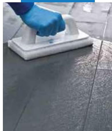
Čistenie škár s použitím Scotch-Brite® (po čiastočnom zatuhnutí)
